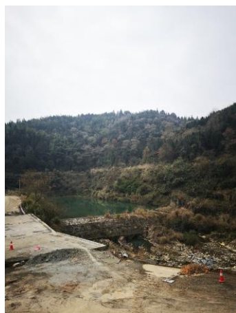
项目地南侧稔禾溪
