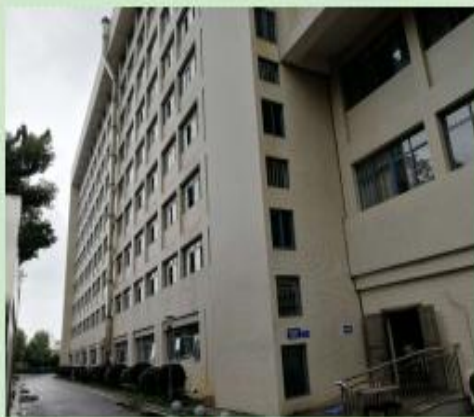
项目北面综合楼
