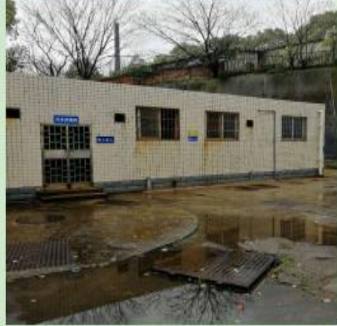
项目污水处理站
