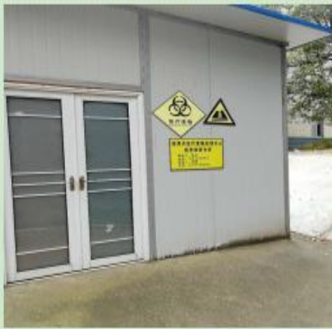
项目医疗废物暂存间
