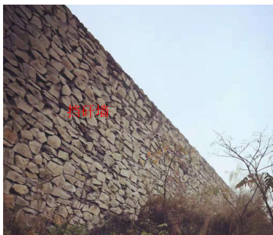
图 5.1-2 矸石堆下游挡矸墙现状图
