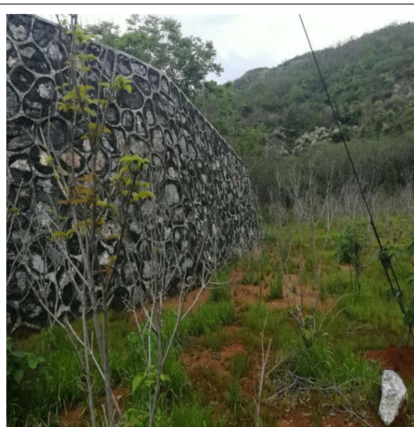
宝山矿区 1#塌方点治理后现状图
