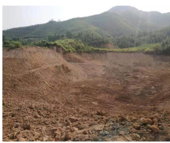
上银山村背面山坡尾矿库现状图
