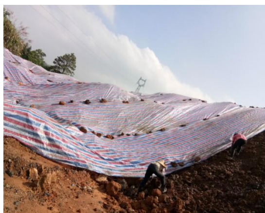
场地施工篷布覆盖
