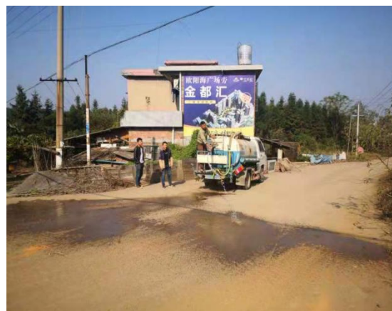
施工道路洒水降尘
