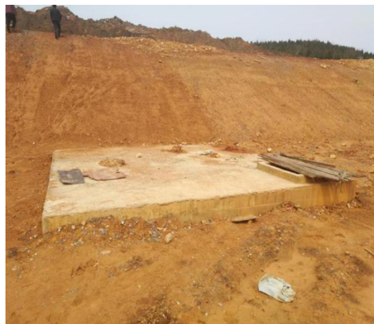
渗滤液收集池
