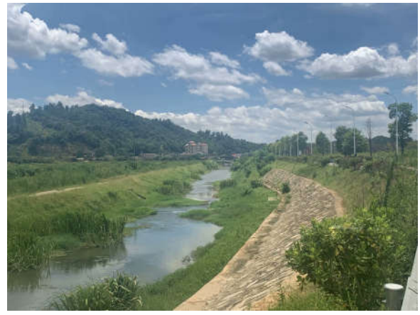
河流穿越段两侧堤坝恢复情况
