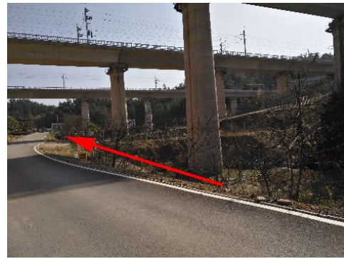
穿越长株潭城际铁路情况
