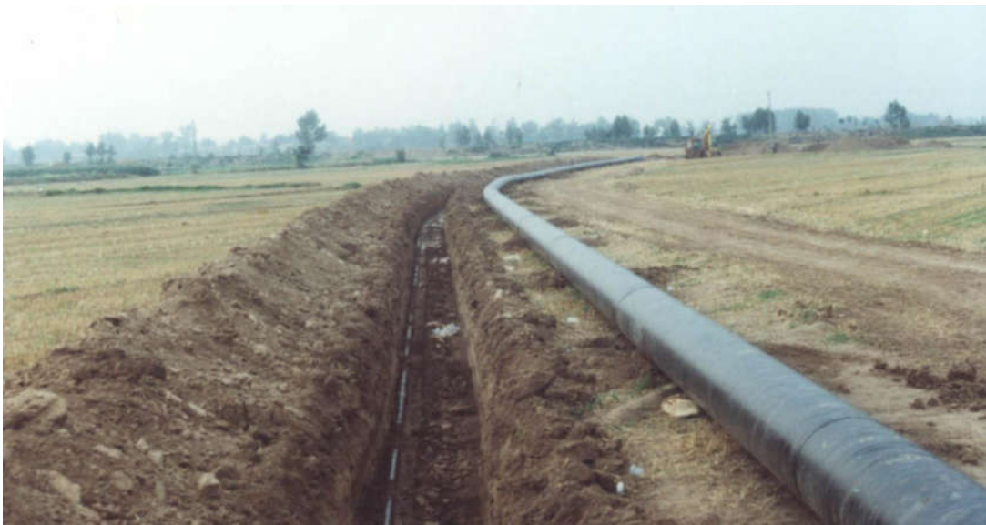
图 2.2-9 管沟开挖及布管实景图
