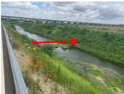
穿越撇洪渠（暮云河）情况
