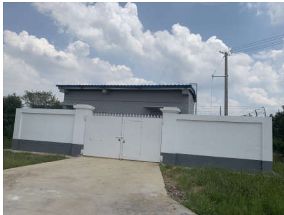
团然村阀室占地生态现状
