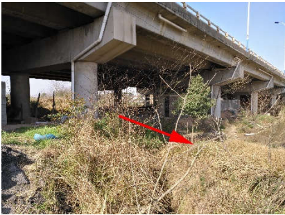
穿越芙蓉大道情况
