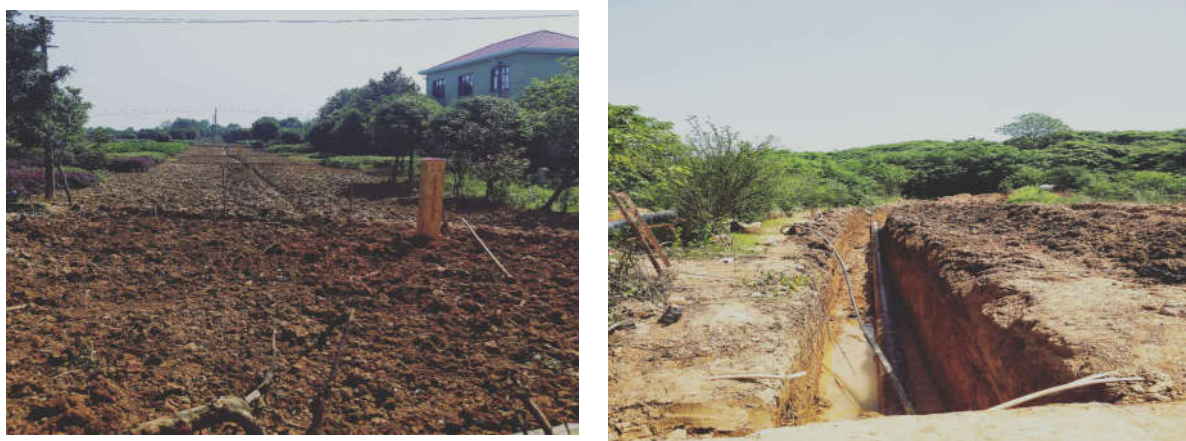
施工期地貌情况
