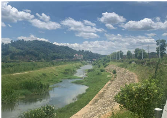
沿线建成的水土保持护坡
