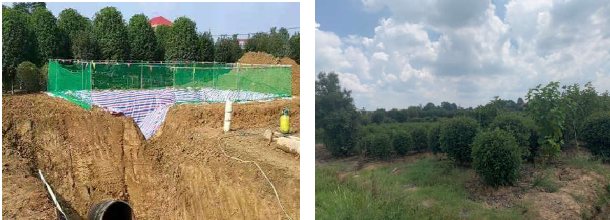
图 5.2-2 临时泥浆池设置情况
