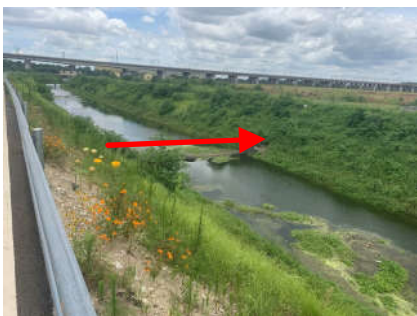
穿越撇洪渠（暮云河）情况
