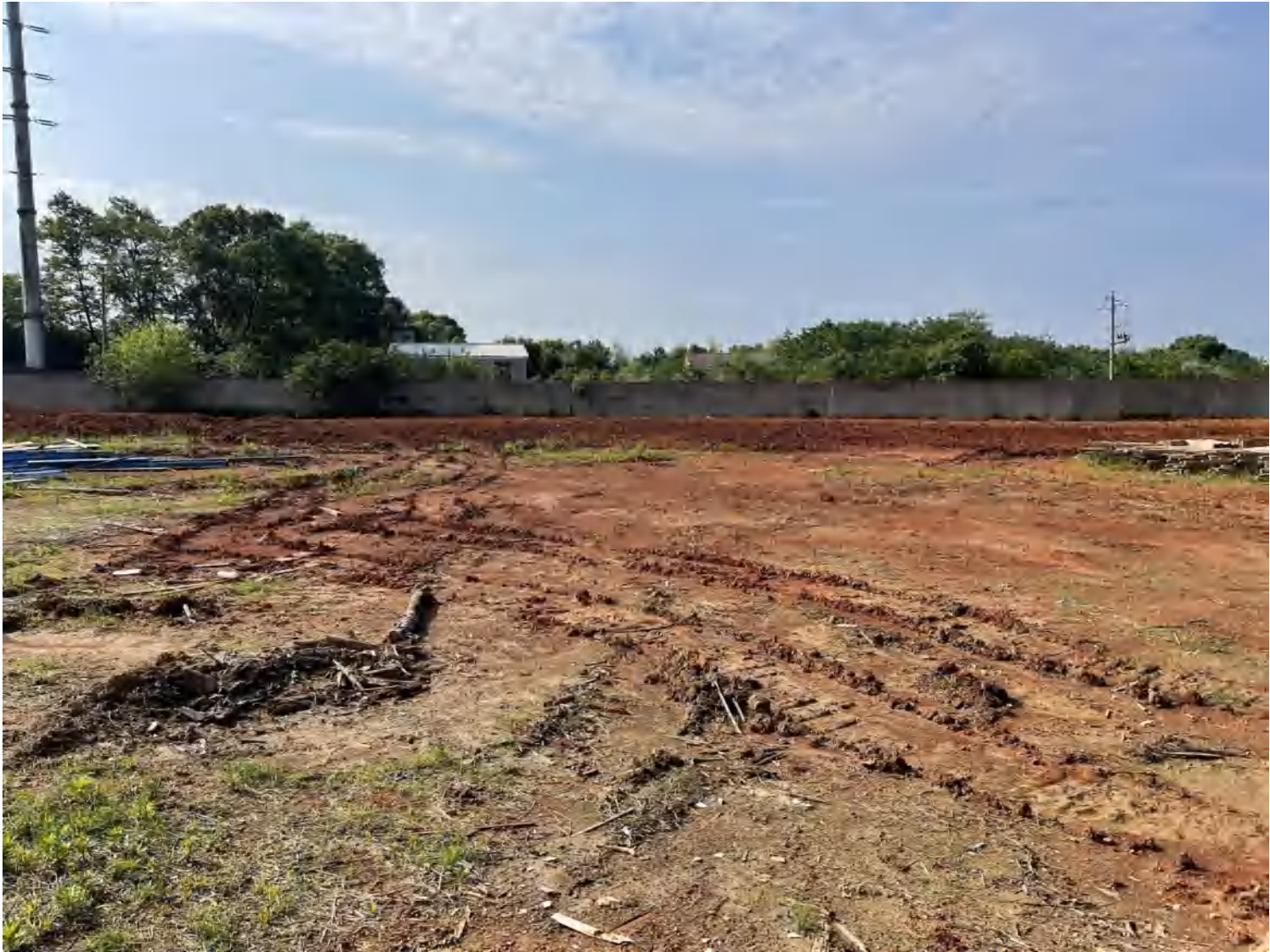
附件 7：现场勘查照片
