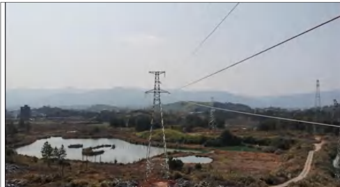
平地区域塔杆架设现状
