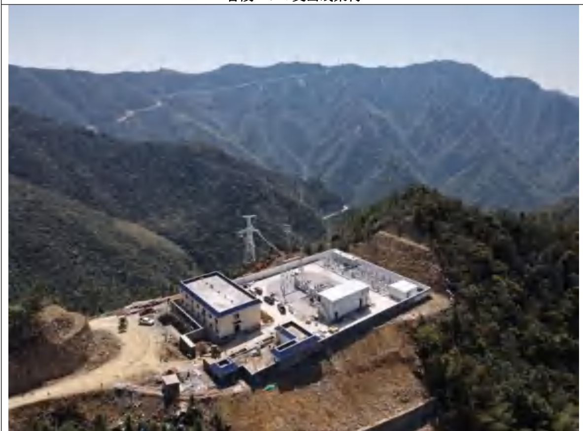
五星岭风电场110kV升压站出线架构
