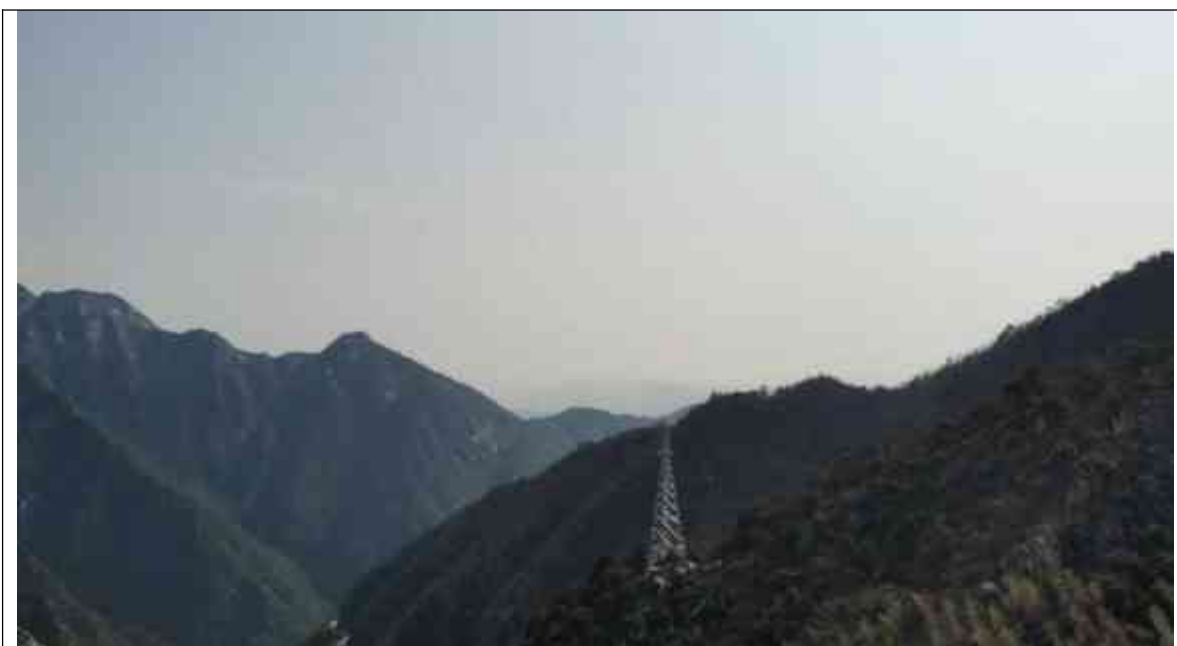
林区、山地区域杆塔架设现状
