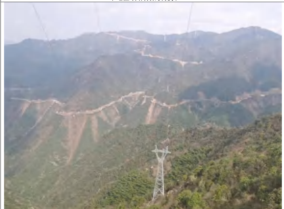
林区、山地区域杆塔高跨架设现状
