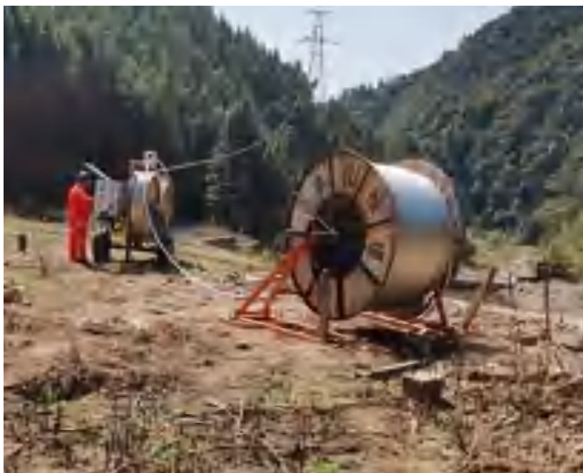
图8-2施工期牵张机临时占地情况
