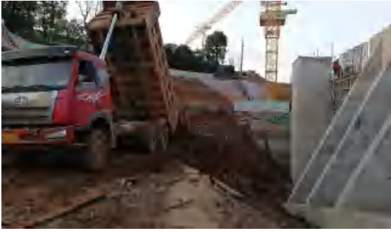
开挖土石方回填
