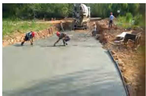
施工道路硬化
