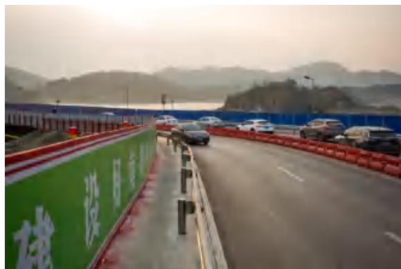
钢便桥道路运行
