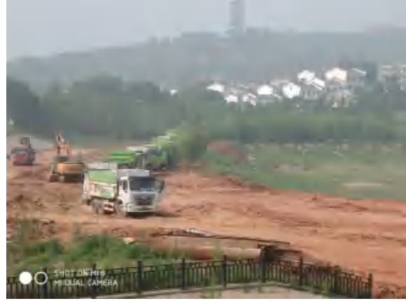
开挖土石方回填
