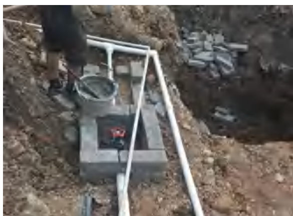
排水系统施工
