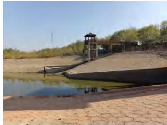
排水涵处六方块护坡、观光栏杆恢复
