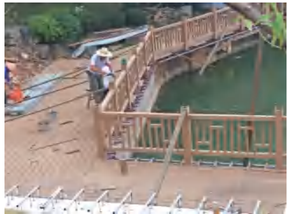
栏杆、栈道修复
