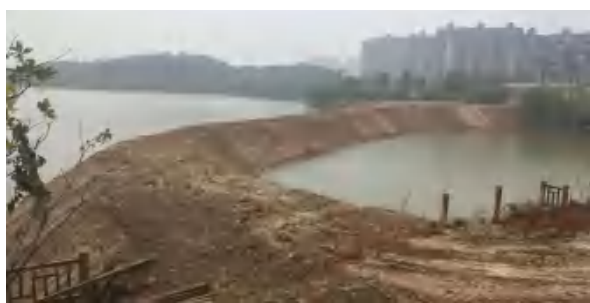
内湖围堰施工
