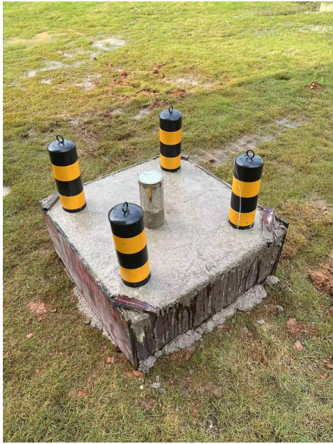
2#地下水监测井（2#事故应急池西北侧）
